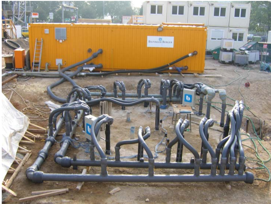
Fig. 5.13. Exemplu de amplasare a distribuitorului/colectorului și a sondelor de înghețare
